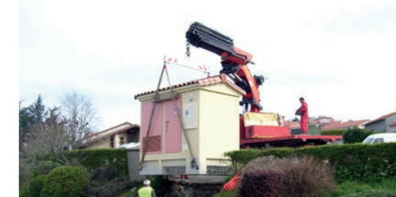
Mise en place d'un nouveau transformateur.
