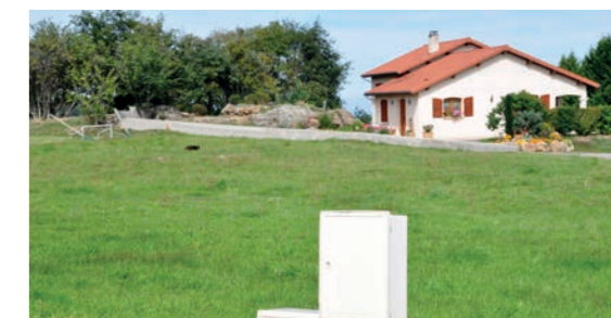
Coffret coupe-circuit en limite de propriété d'un terrain à bâtir.
