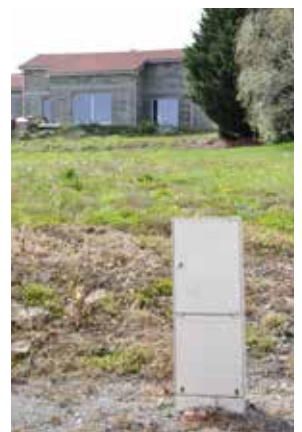
Coffret coupe circuit en limite de parcelle
