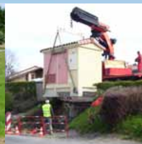
Mise en place d'un nouveau transformateur
