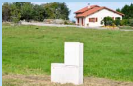
Coffret coupe-circuit en limite de propriété d'un terrain à bâtir
