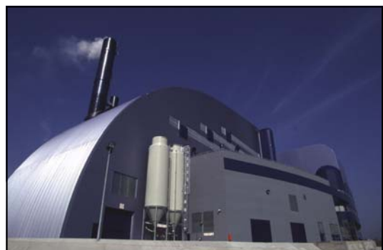
Unité d'incinération d'ordures ménagères
