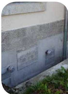
Raccords « pompier » permettant l'insufflation des granulés dans le silo ▶
