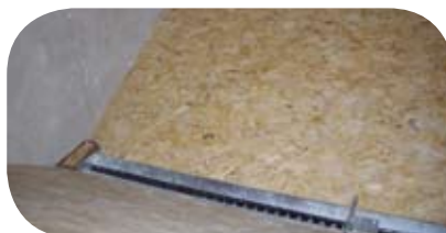
▲ Plancher incliné et vis sans fin centrale dans le silo
